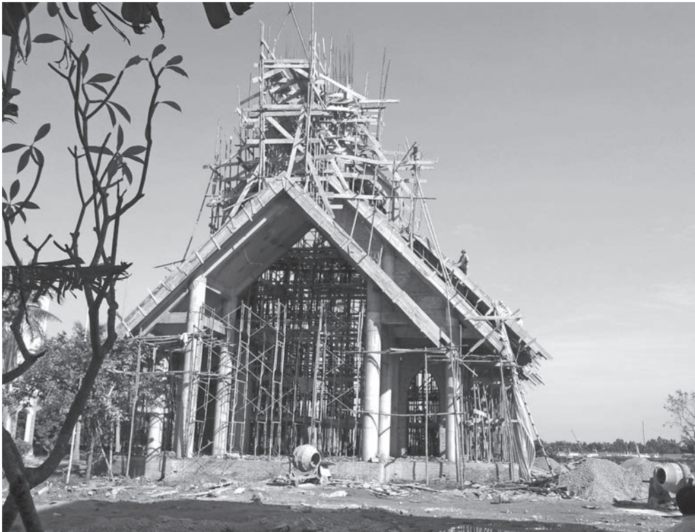
Bau eines neuen Gotteshauses im Norden von Vietnam
